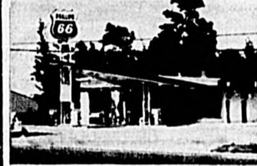
Hiway 66 Service Onora Rd. & Hwy. 17-92
