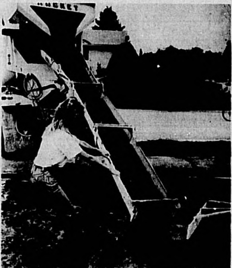
Tammie West pours concrete.
